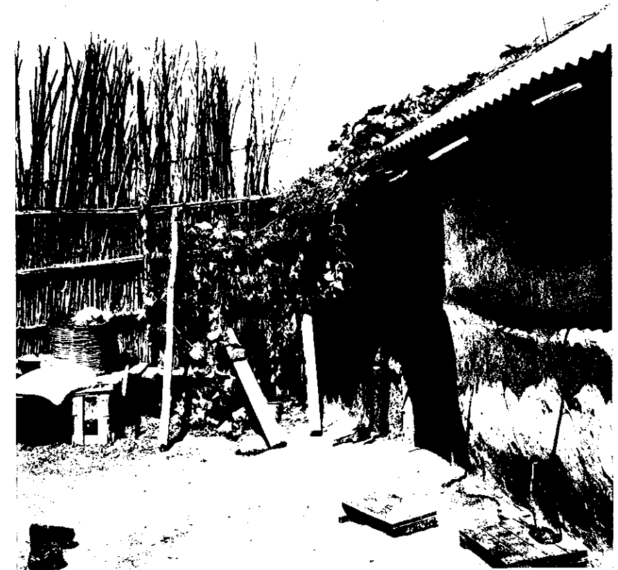
Fig. 7. — INTÉRIEUR D'UNE COUR DES TROIS-ÎLOTS. Tandis qu'une partie de la toiture est encore en feuilles de roseaux séchées, une partie a été recouverte d'une tôle ondulée.
